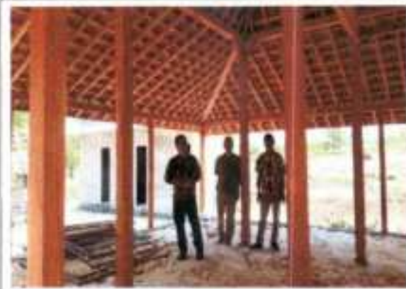
Monitoring pelaksanaan Dana Keistimewaan DIY di Klayar Kedungpoh
